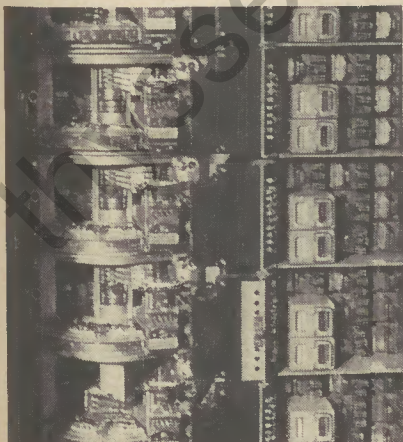
Ausschnitt aus einem Wählerrahmen: Links die „Edelmetall-Motor-Drehwähler“ und rechts die zugehörigen Relais
