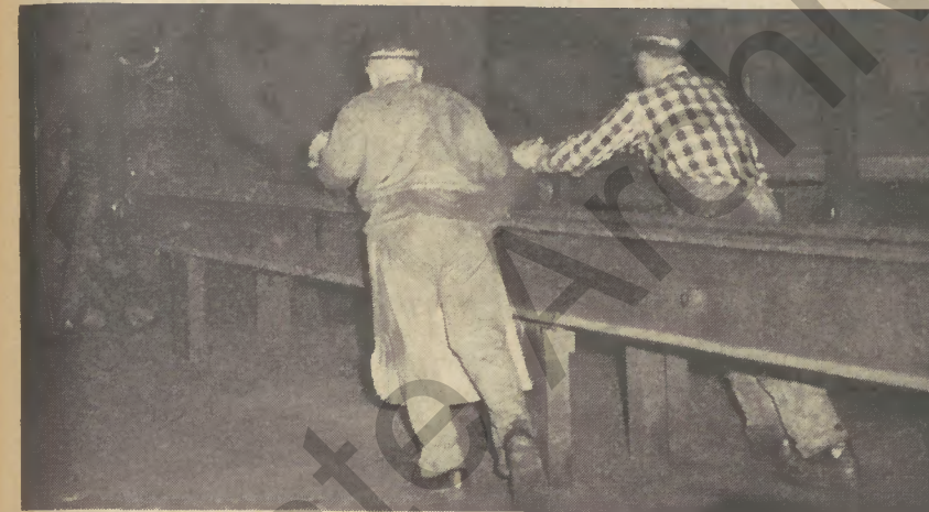
In der Rohr-Warmzieherei wird der Vorschubwagen, mit dem der Knüppel in die Schere eingeführt wird, von Hand vorwärtsbewegt
