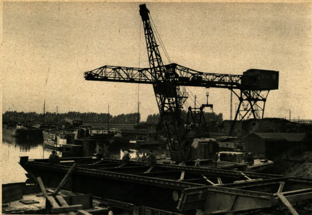
10 Im Erzhafen der Hoesch-Westfalenhütte entsteht der „amphibische Hafen“. Die „Landebahn“ wird eingebracht
