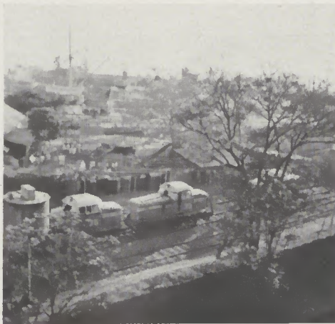
Schichtwechsel der DH Lokomotiven im Hafengelände von Bombay
