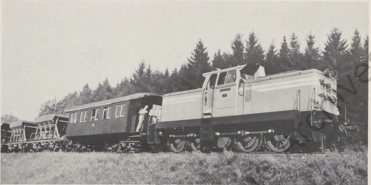
DH 650 auf der Strecke der Marburger Kreisbahn. Auf der hier gezeigten Steigung von 20‰ kann die Lokomotive eine Last von 350 Tonnen anfahren und auf etwa 11 km pro Stunde beschleunigen
