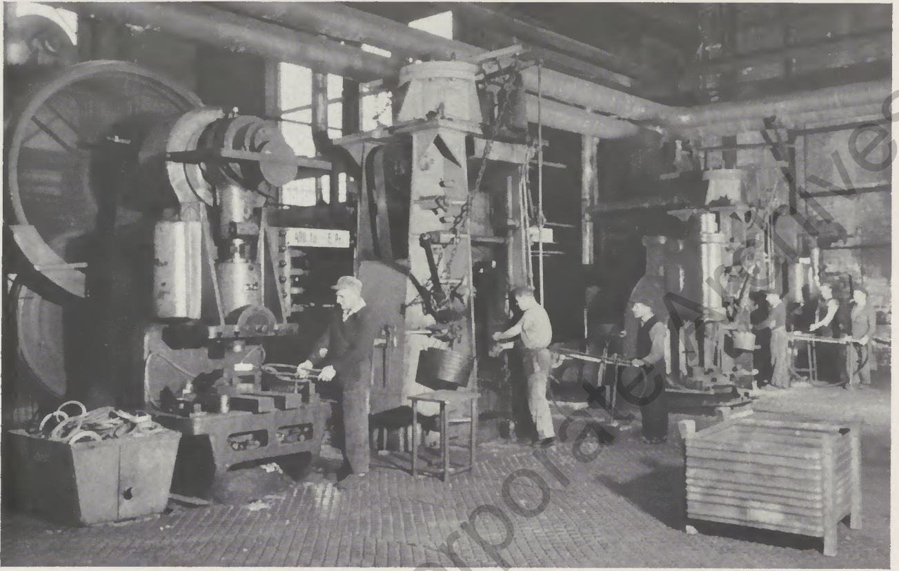
Blick in die Gesenkschmiede; Doppelgesenkhämmer von 6000 mkg und 4000 mkg Schlagleistung
