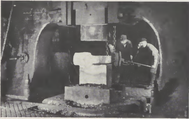
Schmieden einer Kuppelstange unter dem 3000 kg Dampfhammer
