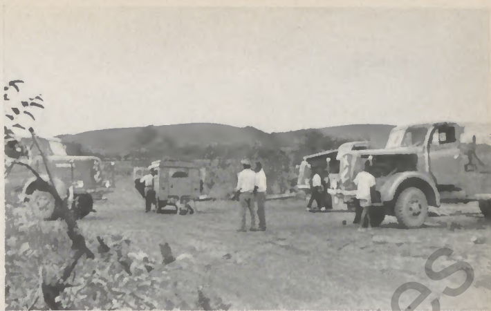
Hier auf dieser Baustelle in Kimongo (Franz.-Äquatorial-Afrika) im Gebiet von Moyen Congo laufen mehrere Henschel HS 140
