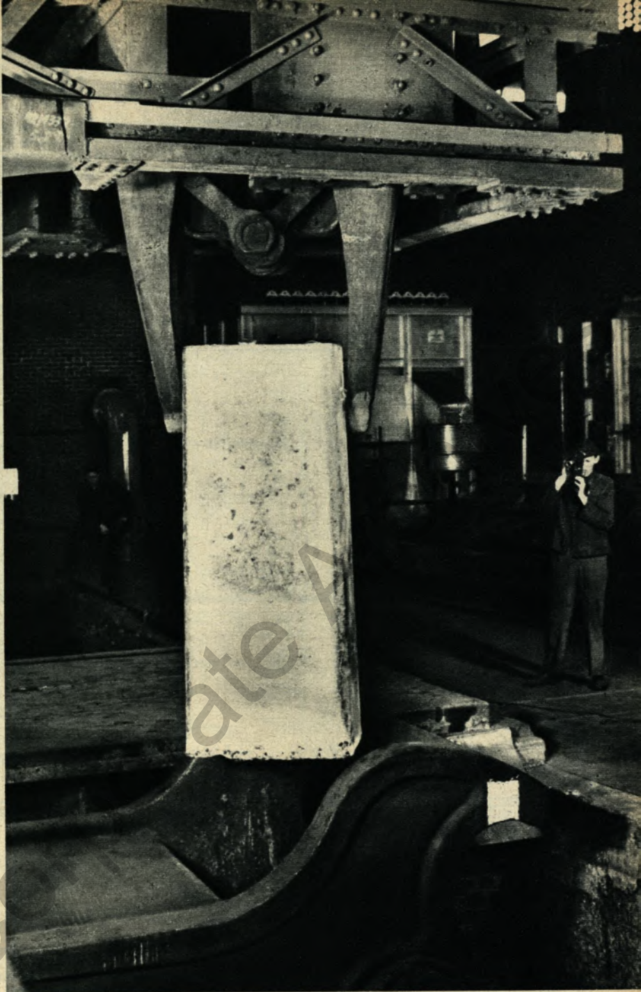
Mit dem Tiefofenkran wird die Bramme in den Blockwagen transportiert, der sie zur Walzenstraße bringt, auf der sie weiterverarbeitet wird.
