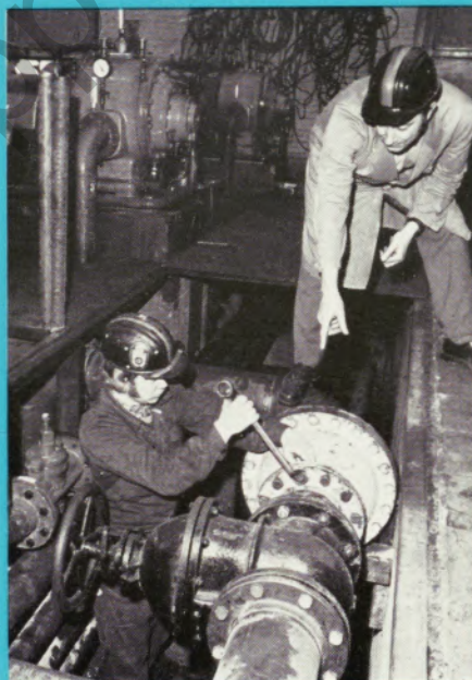
Der Inbetriebnahme des Großverdichters für ölfreie Preßluft gingen umfangreiche Montagearbeiten voraus. Seite 4-5.
