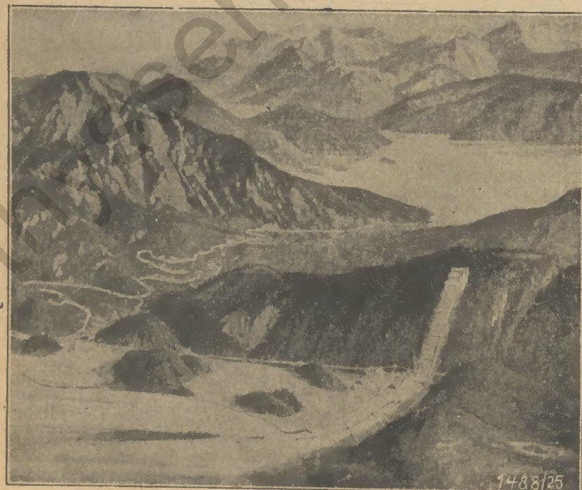
Das Waldensee-Kraftwerk aus der Vogelschau
