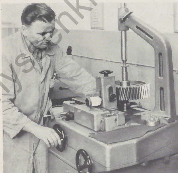
Abb. 5 Prüfen der Evolvente eines Stirnrades. Auf dem Papierstreifen wird die Evolventenkurve aufgezeichnet
