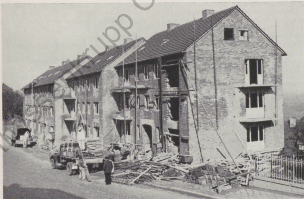
Der Neubau Nordstraße
