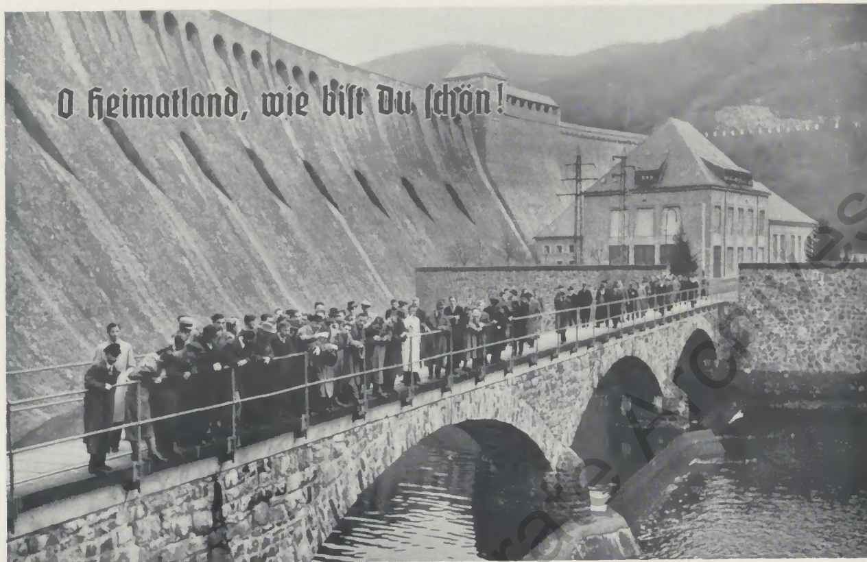
Die Edertalsperre mit dem Kraftwerk Hemfurt I und II wird besichtigt
