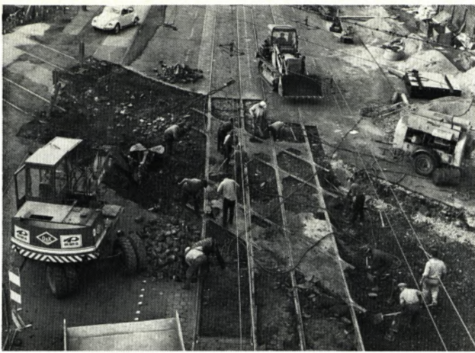
Ausbauen der alten Kreuzung
