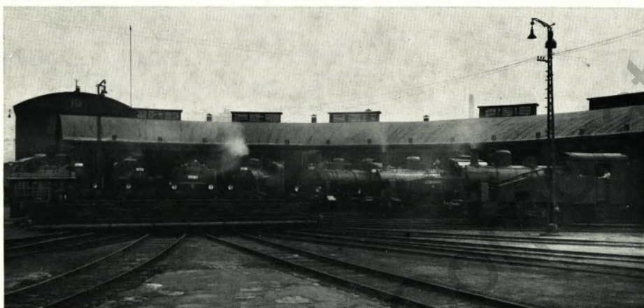
Der 1913 fertiggestellte Ringschuppen mit der davorliegenden Drehscheibe und einer kleinen „Dampflokgarde“.
