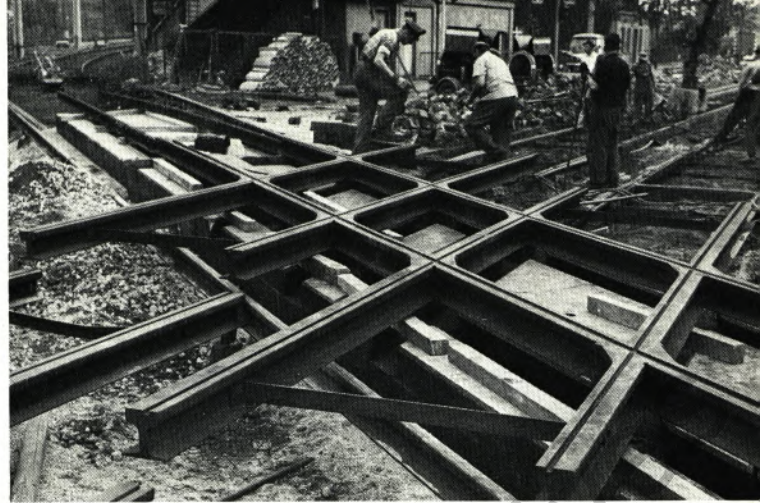
Die neue, voll miteinander verschweißte Kreuzung vor dem Einbau
