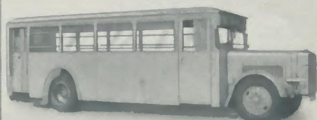
Henschel-Dampf Omnibus, TYP 4Z1 Fassungs-Vermögen: Bis 50 Pers.
