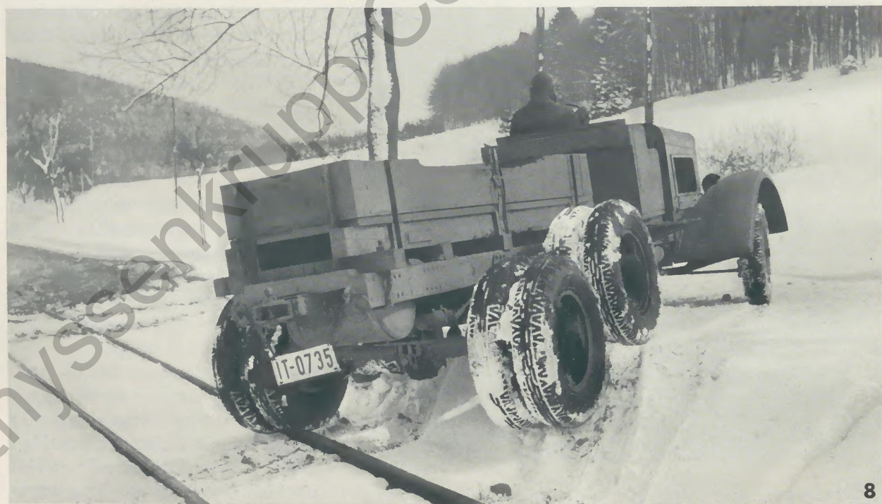
GELÄNDEGÄNGIGES DREIACHSFAHRGESTELL FÜR 4250 kg TRAGFÄHIGKEIT Doppelte Bereifung der Hinterräder; Reifen haben großen Abstand von einander zwecks Aufnahme einer Gummi-Raupenkette; Räder erklettern ohne Schneeketten die Böschung; zwangloses Schiefstellen der Achsen zu einander
