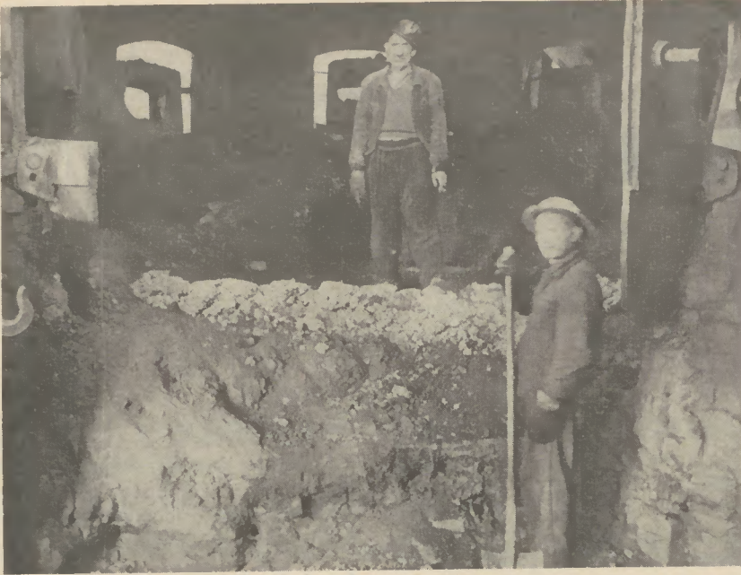
Die freigelegte „Hochofensau“. Deutlich ist auf unserem Bild der geöffnete Stahlpanzer zu sehen, welcher das bereits herausgebrochene Mauerwerk ummantelt. Die im Panzer sichtbaren Öffnungen sind für die Düsenstöcke bestimmt – insgesamt 6 Stück an der Zahl –, durch welche der Heißwind mit ca. 900° C als Gebläsewind in den Ofen geleitet wird.
