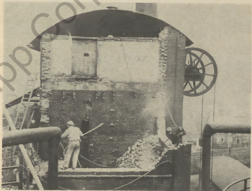
Die Arbeiten am Förderthurm
