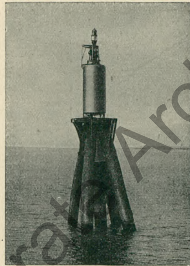
Azetylen-Leuchtbake auf einer Düddalbe im Trave-Kanal.
