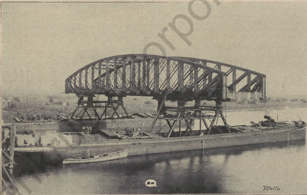
Noch ein interessantes Bild vom Ausschwimmen der alten Weserbrücke Bremen-Dreye durch die Dortmunder Union
