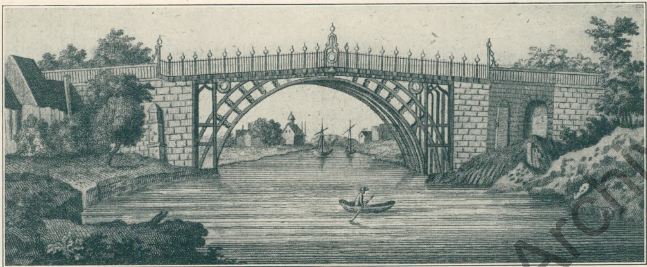
Abbildung 4. Gußeiserne Brücke über den Sebern bei Coalbrookdale. Aus Hülfts Handlungszeitung 1790, S. 33—36.
