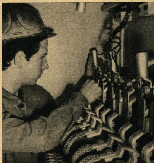
▼ Werner Meyer, auch aus der „Mannschaft“ der kommenden Facharbeiter, arbeitet nebenan an der Steuerung der genannten Widerstände. Auf unserem Bild ist er dabei, die „Schütze“ in den Läuferschützenschrank einzubauen und die Kabelschuhe anzupassen, die später die Bündel von Kabeln aufnehmen sollen
