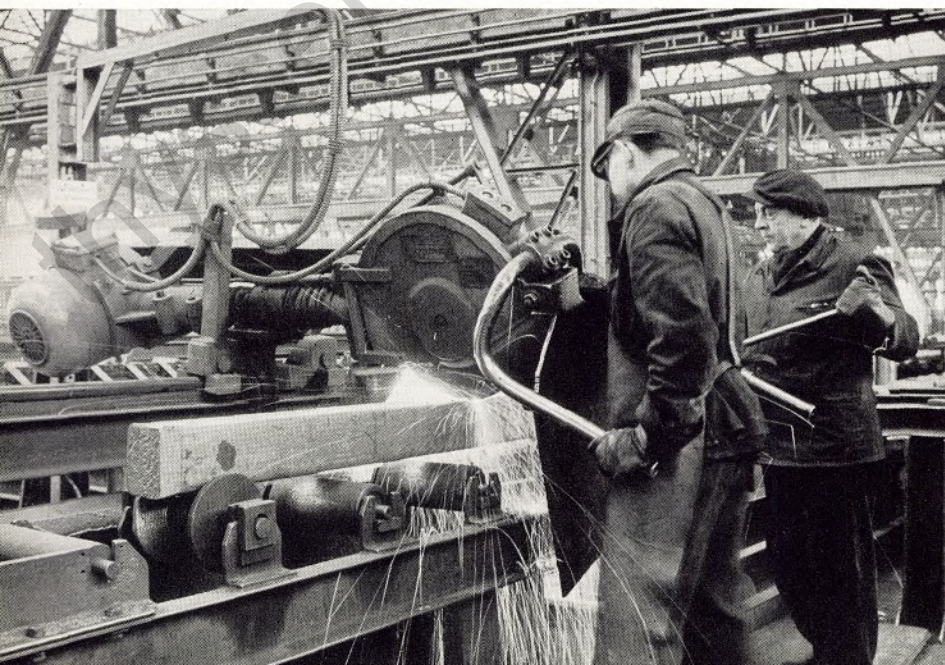
Kurt Renner und Josef Cerniva an der Pendelschleifmaschine beim Schleifen von Halbzeug
