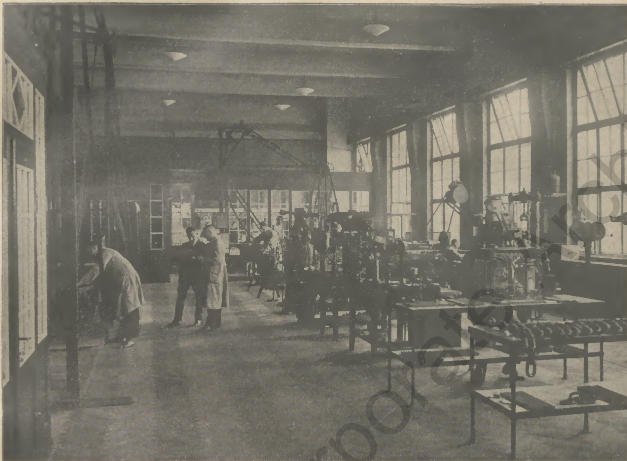
Saal für Festigkeitsuntersuchungen im Forschungsinstitut
