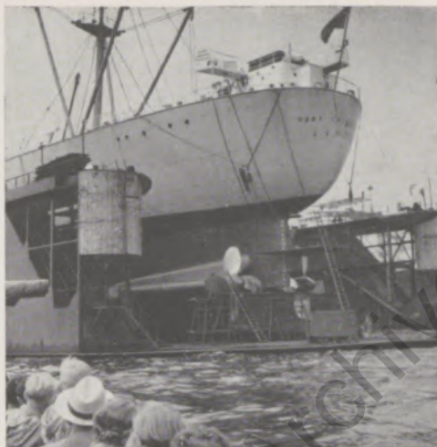
Ein „Engländer“ im Trockendock. An den beiden riesigen Schiffsdrauben werden Ausbesserungsarbeiten vorgenommen und der Rumpf von Tang und Muscheln gereinigt
