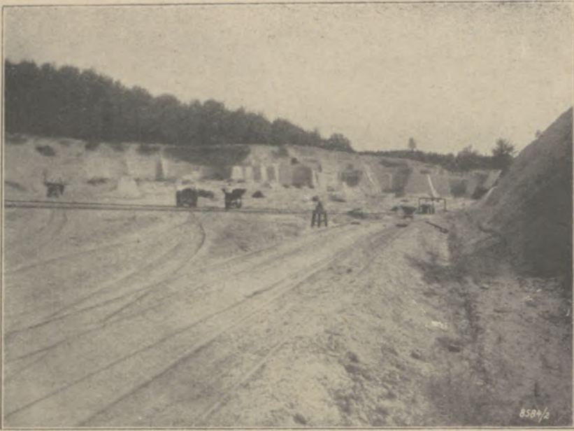
Blick auf die Formsand-Lagerstätte. (Der Sand wird von Hand abgestochen, in Lören verladen und durch Seilbahn zur Verladestation gebracht.)
