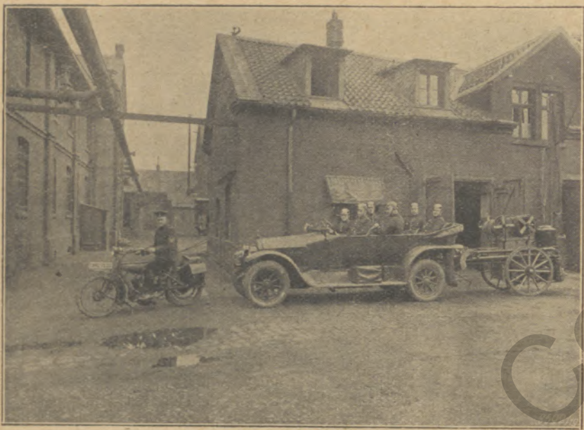
Abb. 5: Bei Bränden von flüssigen Brennstoffen, wird hinter den Wagen ein Fahrzeug gehängt, das die modernste Einrichtung zur Bekämpfung derartigen Feuers trägt: den Minimax-Schaumlöschgenerator
