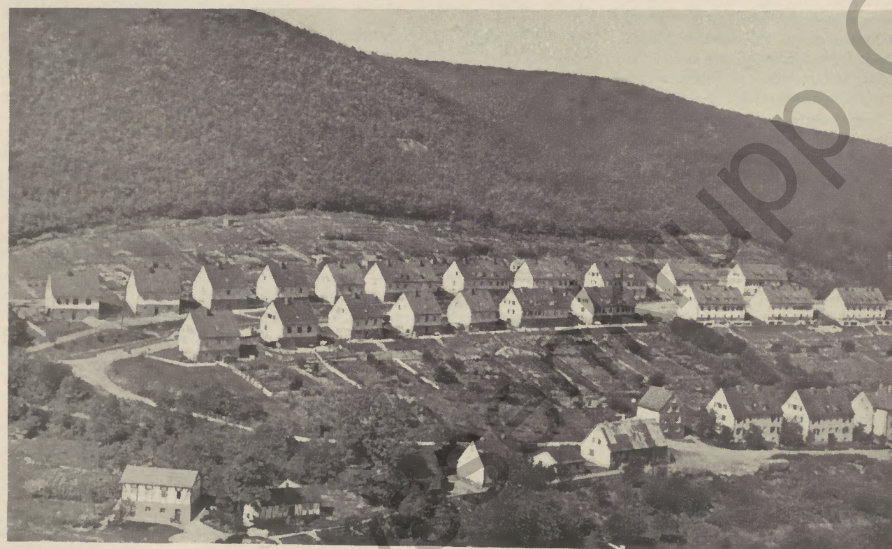
Selbsthilfesiedlung »Am eisernen Keil«, Niederschelden, I. Bauabschnitt: 22 Siedlerwohnungen mit 22 Einliegerwohnungen, II. Bauabschnitt: 10 Siedlerwohnungen mit 10 Einliegerwohnungen
