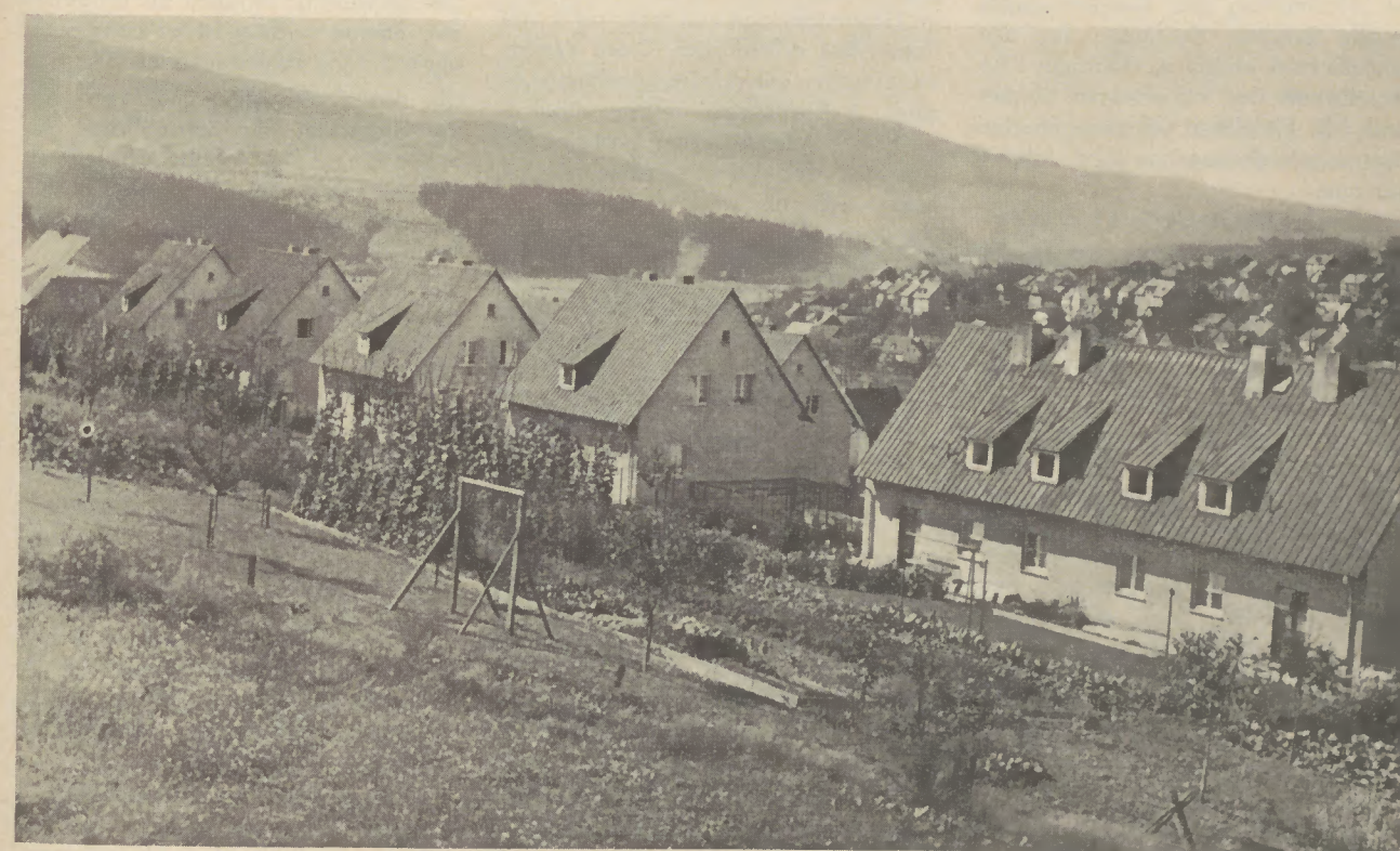
Teilansicht der Selbsthilfesiedlung »Kronenacker«, Mundersbach, I. Bauabschnitt: 10 Siedlerwohnungen mit 10 Einliegerwohnungen, II. Bauabschnitt: (noch im Bau befindlich) 20 Siedlerwohnungen mit 20 Einliegerwohnungen.
