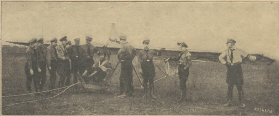
Gleitflugzeug „August Thynsen“, Bauart Zögling; gebaut von der HJ.-Fliegerschar II/1/236 in der Werkschule der Thynsen-Hütte in 2115 Arbeitsstunden
