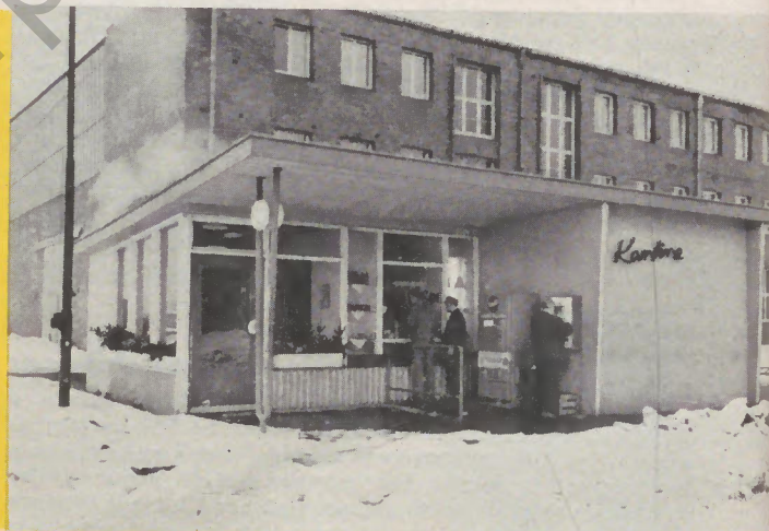
Einer der Kantinen-Pavillons im Werk Mittelfeld
