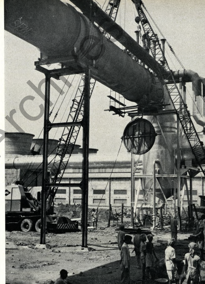
Ein entscheidender Augenblick ist gekommen. Eine Drosselklappe — es war die schwerste, die in Rourkela eingebaut worden ist — wird hochgehievt. Arbeiter schauen gespannt zu
