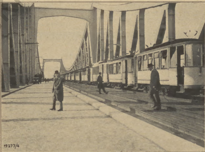
Der erste Straßenbahnzug auf der neuen Düsseldorf-Neusser Rheinbrücke am Tage der Einweihung
