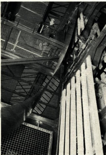
Rückseite: Auch der Schlingenturm gehört zur Durchlaufglühanlage. In ihm hängen ständig 100 Meter des papierdünnen Bandes zur Reserve, damit keine Stockungen im Arbeitsfluß eintreten
