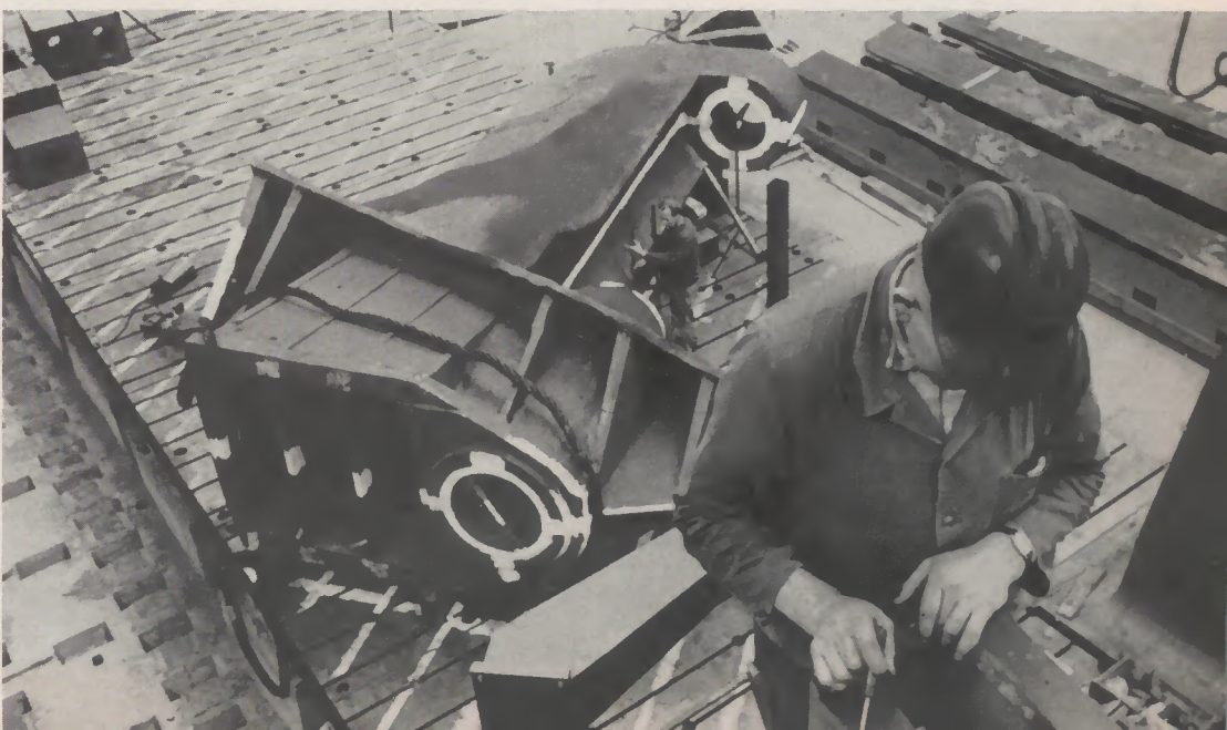
▲ Kurbelwelle auf dem Kurbelzapfen-Drehapparat
