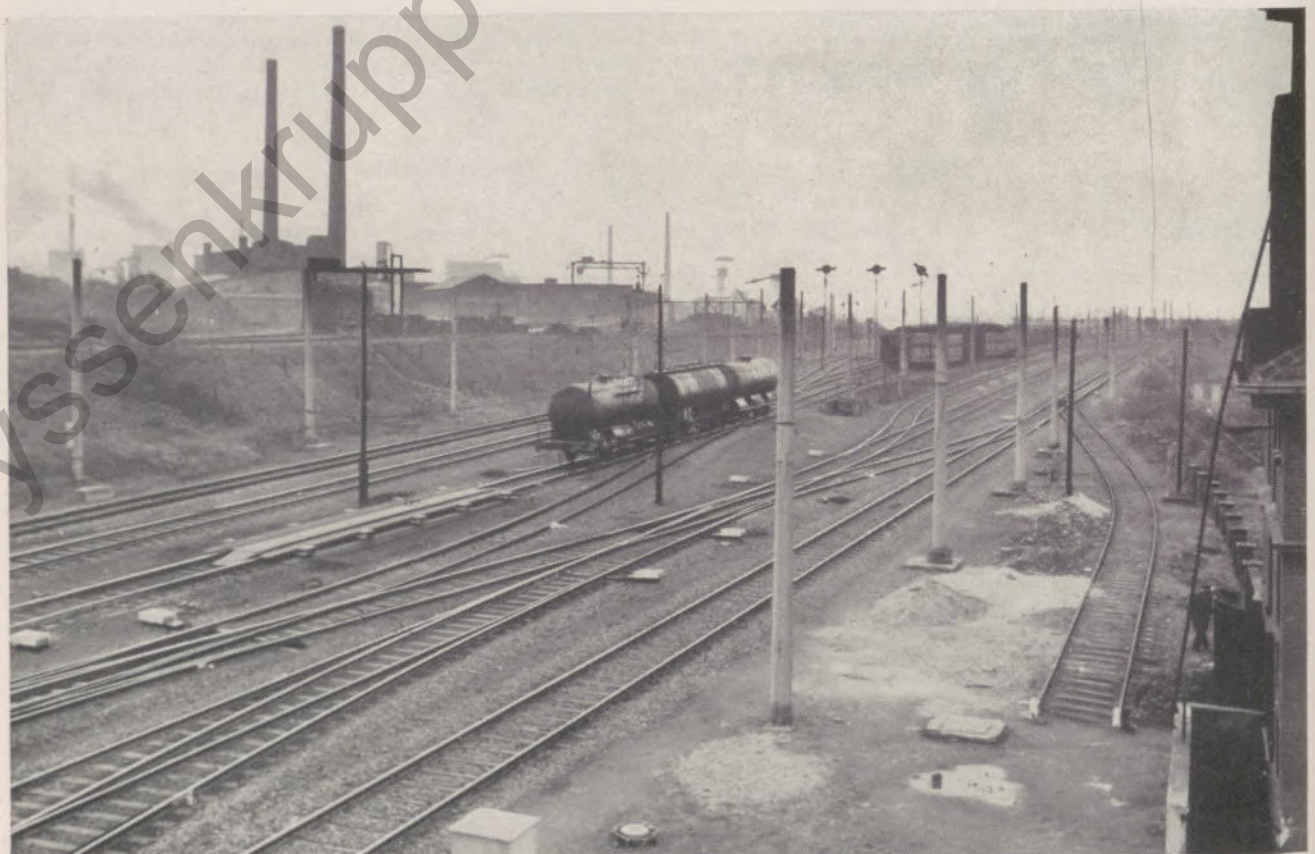
Abbildung 3: Ablaufberg mit Kesselwagen kurz vor der Gleisbremse
