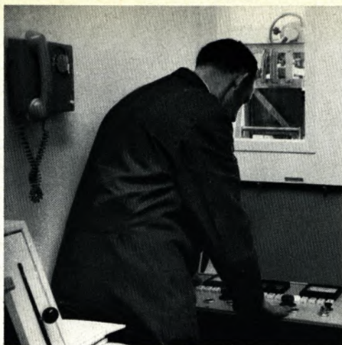
Arbeit am Steuerpult der Röntgenanlage. Vor dem Gesicht des Werkstoffprüfers das strahlensichere Beobachtungsfenster.
