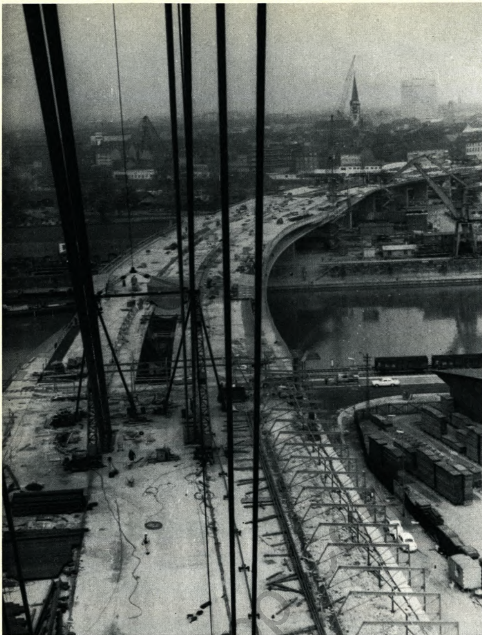
Blick vom Pylon auf Mannheim. Rechts unten im Bild die Eisenkonstruktion der Montagehalle, in der die Paralleldrahtkabel aus den WU-Drähten gefertigt wurden.
