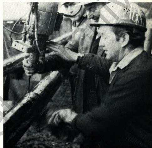
Beschichtung des Seiles mit Polyurethanmasse.
