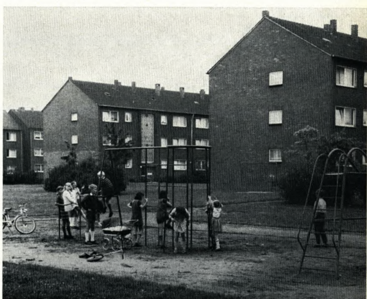
Gelsenkirchen, Kinderspielplatz vor den Wohnhäusern Alfred-Zingler-Straße, Baujahr 1963
