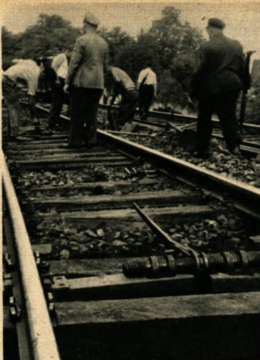
5 Bundesbahnarbeiter beim Bau einer Strecke mit Doppelschaft-Federnägeln
