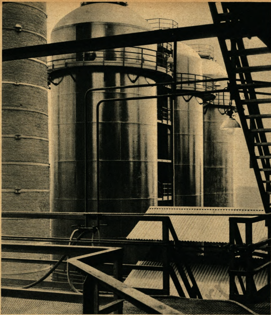
◀ Die drei neuen Winderhitzer für Hochofen IV sind betriebsbereit
