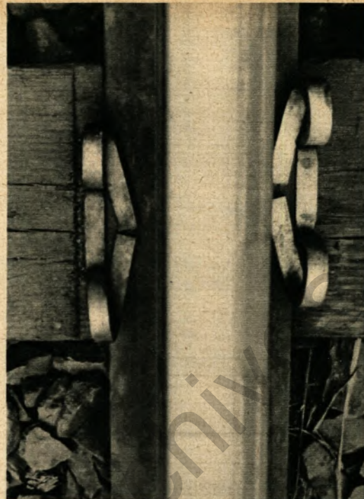
6 Wenn man genau hinsieht: Der Doppelschaft-Federnagel auf einer Hartholzschwelle ohne Unterlagplatte
