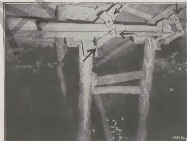
Abb. 2: Vorpfändung mit angeschraubten Fanghaken
