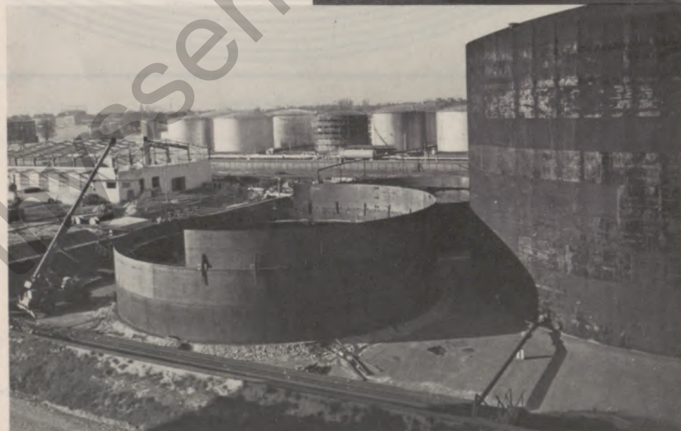
Blick auf eine Raffineriebaustelle, wo aus fertig kantenbearbeiteten und gebogenen Blechen ein Lagertank gebaut wird.
