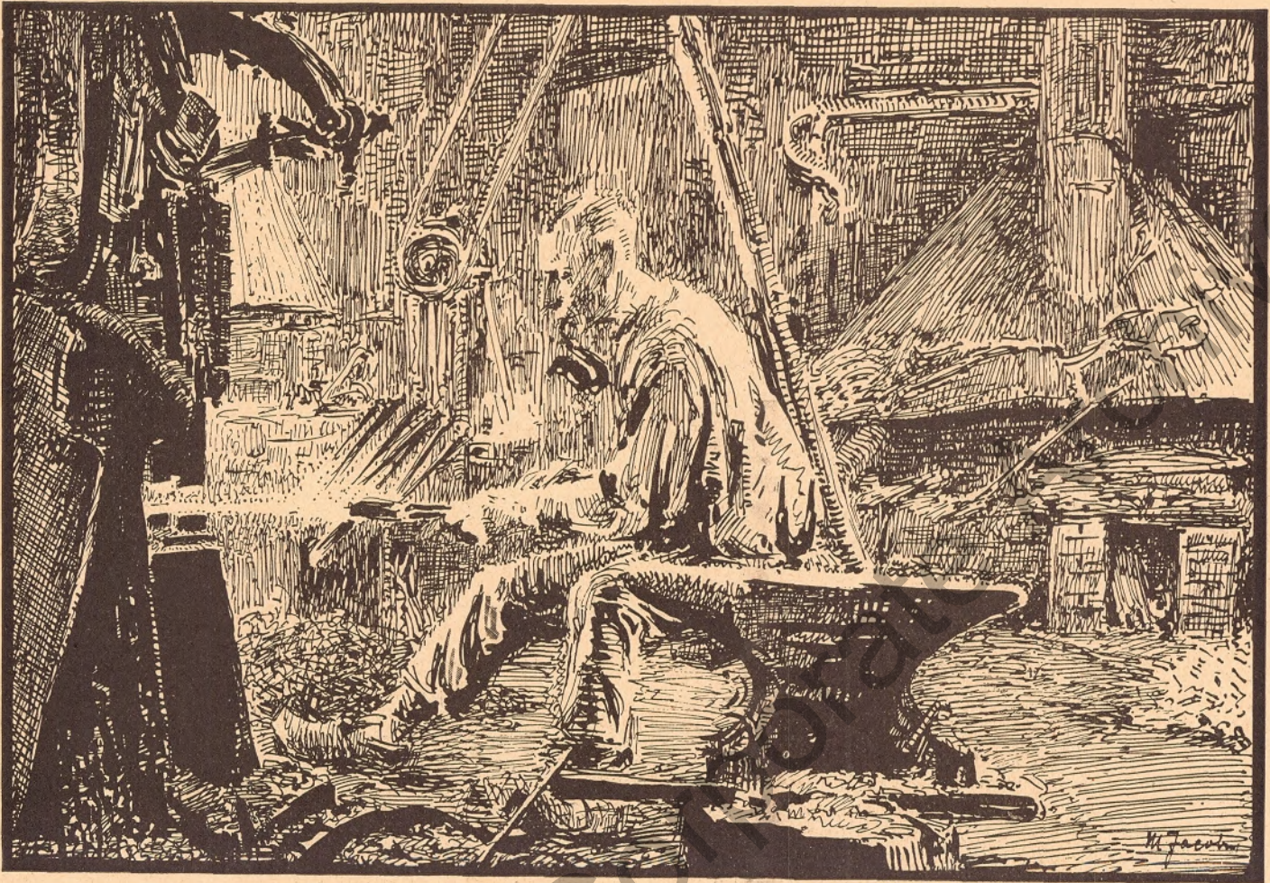
Federhammerschmiede für Sabeln — Die Zinken einer Szinkigen Steingabel werden einzeln ausgereckt
