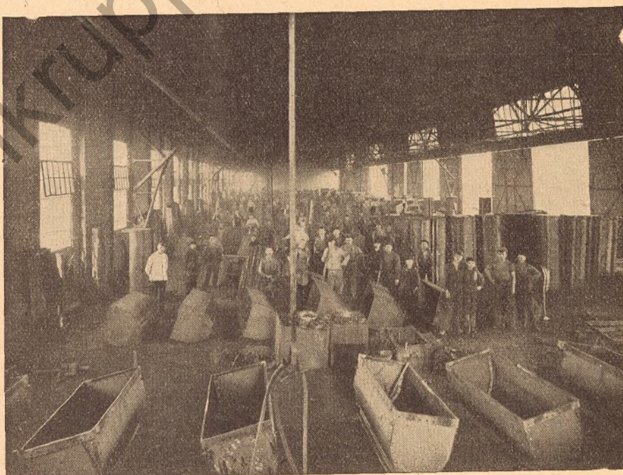
Große Riehhalle — Die Förderwagenlärken werden mit Preklusthämmer zusammengeklüftet
