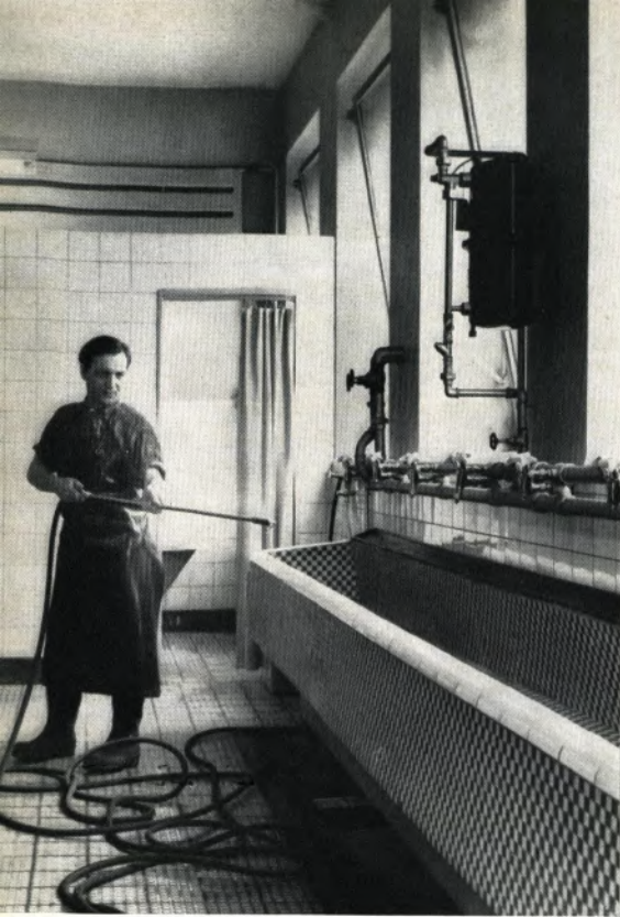
Zur Pflege der Waschkauen gehört auch die Desinfektion. In der neuen Waschkau an der Neustadtstraße bedient hier Paul Wojczikowski eine moderne Zerstäubungsanlage
