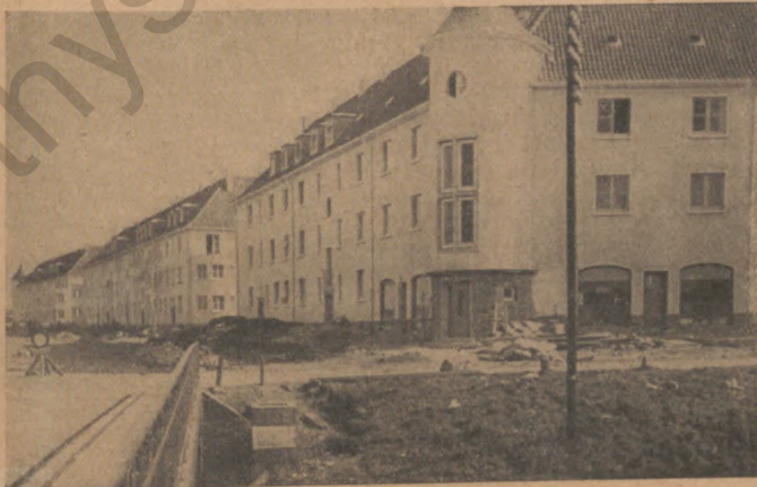
An den begonnenen Bauten wird emsig weitergearbeitet
