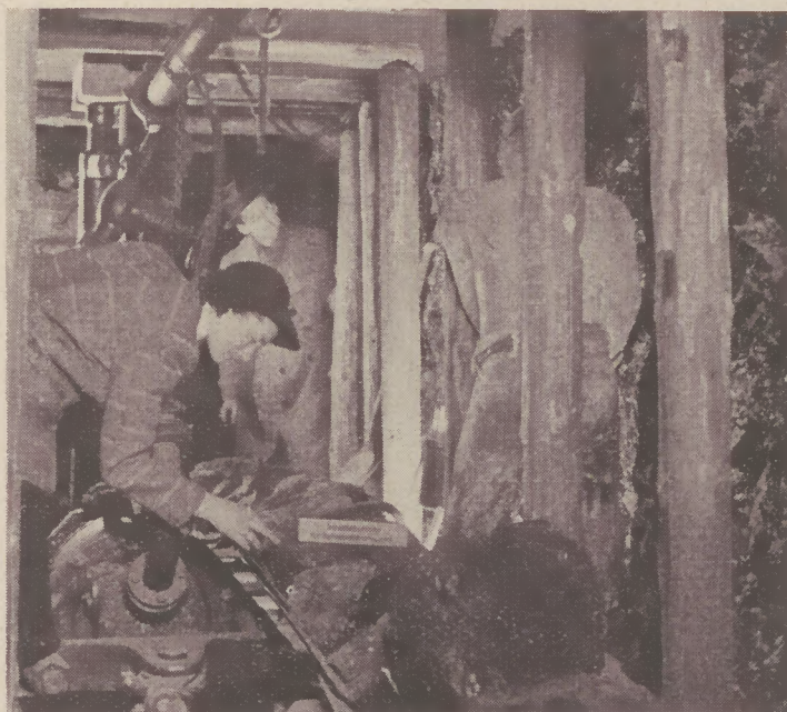
Neuzeitlicher Kohleabbau in der Gruppe Schachtbau
