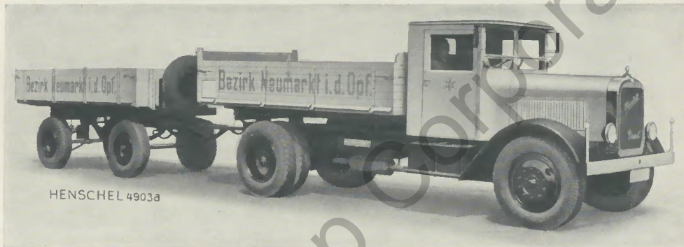
Eine Serie Henschel-Diesel-2 3 / 4 -Tonner, Typ 28 O 1, mit Spezialkastenaufbau für Flaschenbiertransporte der Elbschloß-Brauerei, Altona-Nienstedten.
