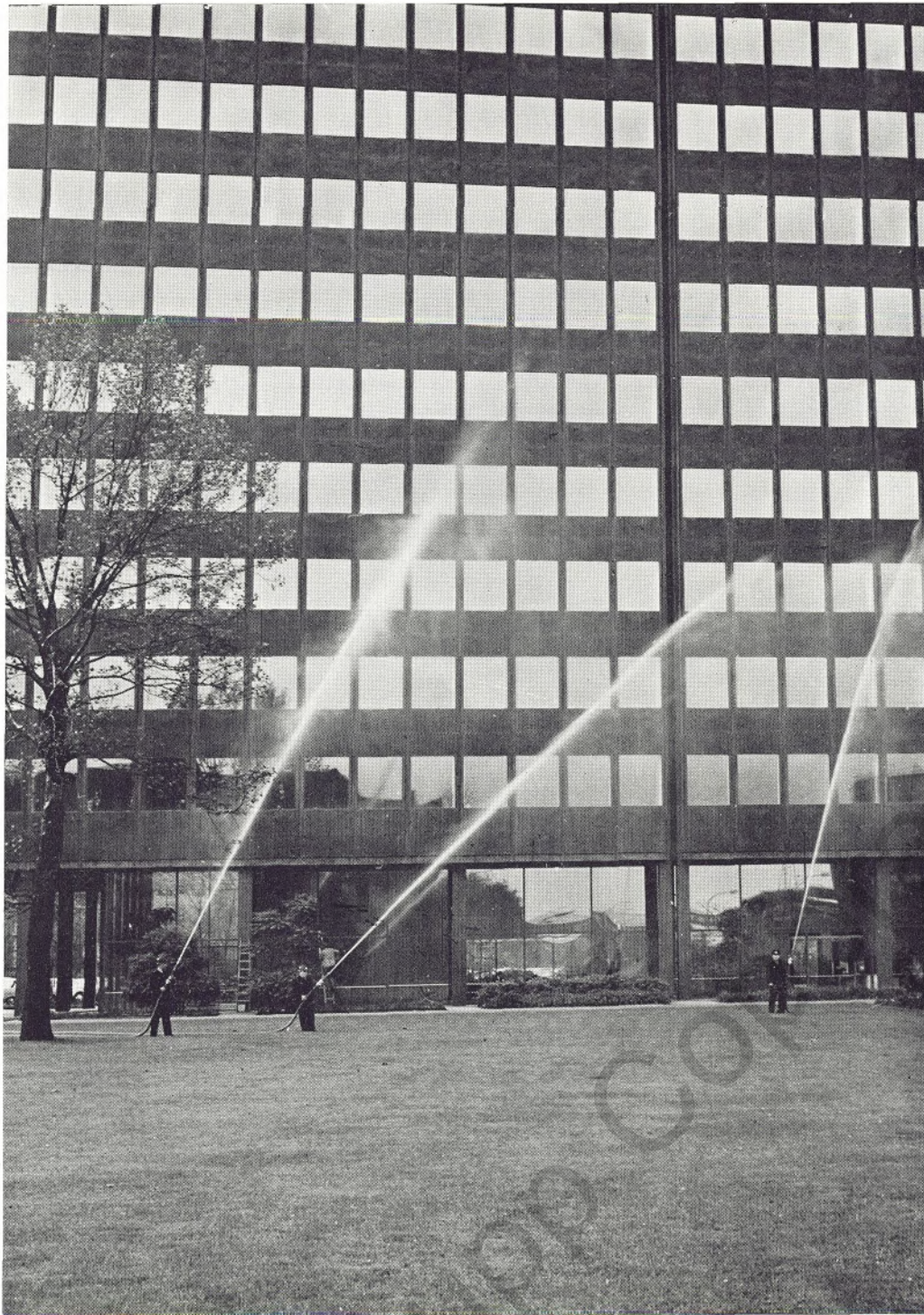
NICHT DES RASENS WEGEN heißt es für die Männer der Werkfeuerwehr vor der neuen Hauptverwaltung „Wasser marsch“. Im Rahmen des vorbeugenden Brandschutzes wird allmonatlich die Wasserversorgungsanlage im Hochhaus überprüft, die bei normalem Betrieb auch genügend Löschwasser hergeben muß
