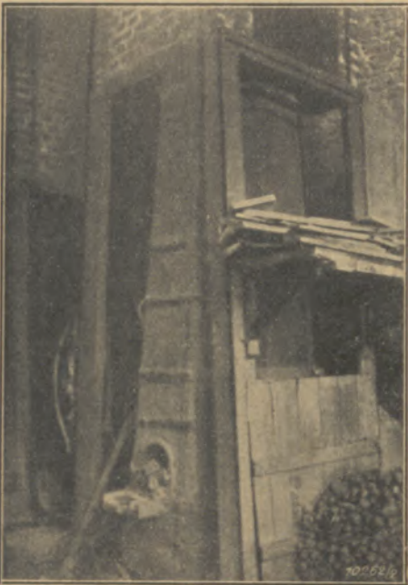
Abb. 8: Einer der guten erhaltenen Kupolöfen
