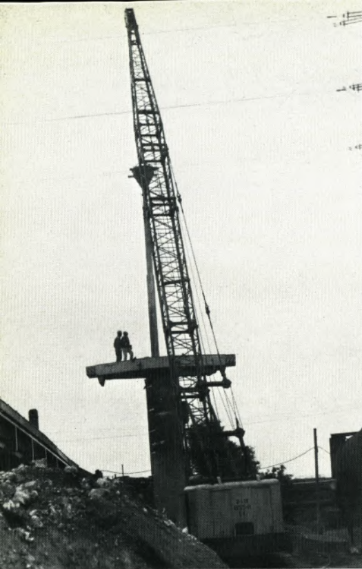
Herstellen eines Bohrpfahles 150 cm Ø für die Widerlager
