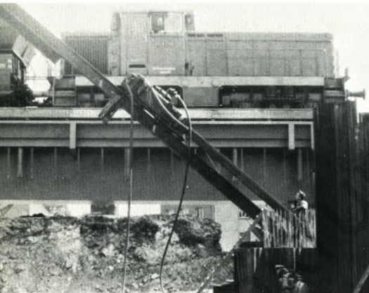
Hier wird ein „MV-Pfahl“ zur Verankerung der Widerlager gerammt
