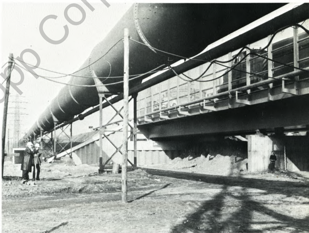
Belastungsprobe an der fertigen Brücke. Verm.-Ing. Peters bei der Ermittlung der Durchbiegung eines Überbaues
