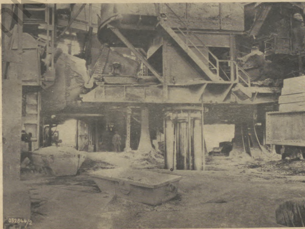
Einkippen von Roheisen in einen Konverter
