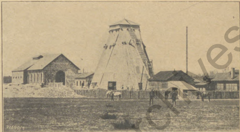
Schacht I. Abgeteuft um 1870
