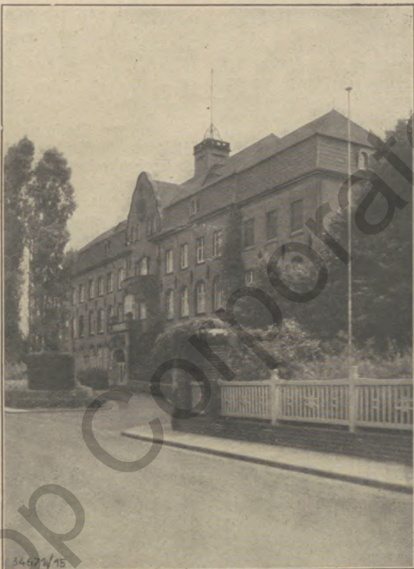
Hauptverwaltungsgebäude der Rheinischen Provinzial-Heil- und Pflegeanstalt in Bedburg
