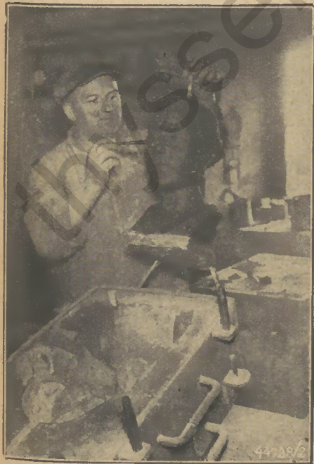
Das Kernstück wird in die Sandform eingehängt
