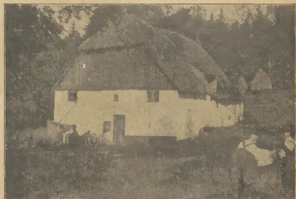
Strohgedecktes Bauernhaus im Dedental
