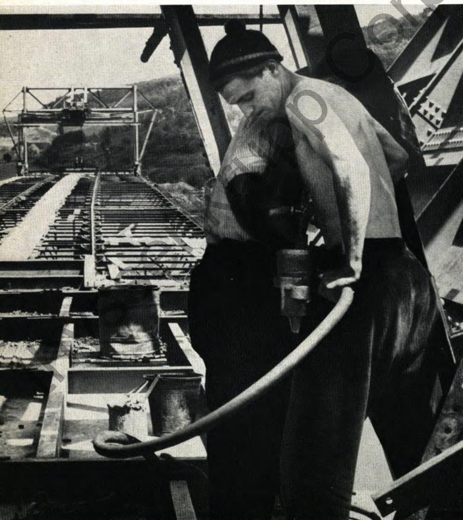
Stück für Stück wuchs die Brücke über das Tal. Hier wird gerade ein neuer Abschnitt angefügt. Mächtige Krane halten die „Wanne“, bis sie mit dem vorangehenden Stück vernietet werden kann. Jeder dieser Abschnitte ist 10,5 m lang
