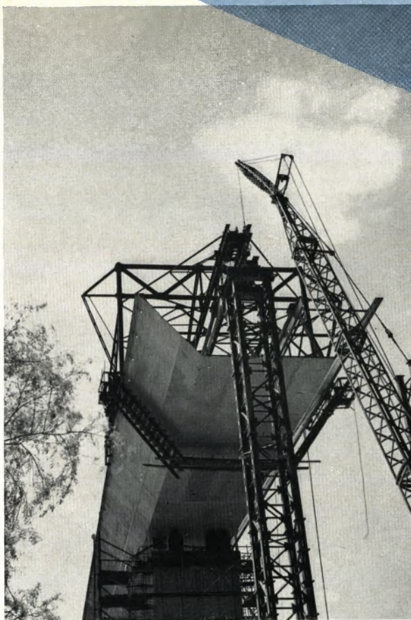
Stück für Stück wuchs die Brücke über das Tal. Hier wird gerade ein neuer Abschnitt angefügt. Mächtige Krane halten die „Wanne“, bis sie mit dem vorangehenden Stück vernietet werden kann. Jeder dieser Abschnitte ist 10,5 m lang
