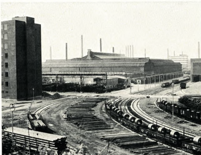
Ein Blick vom Tor 6 unseres Werkes Mülheim auf das ausgedehnte Werksgelände. Vorne links erkennt man den Rohbau der neuen Waschkaue.
