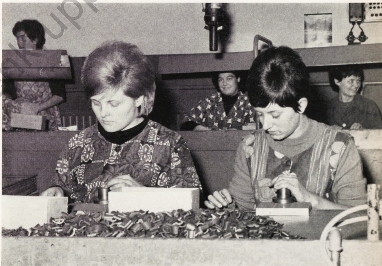
Unsere Mitarbeiterinnen Frau Herder und Frau Lenzen in der Eingangskontrolle bei der maßlichen Prüfung von Oxitmagneten
