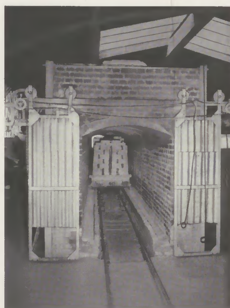
Tunnelofen im Werk Bendorf
