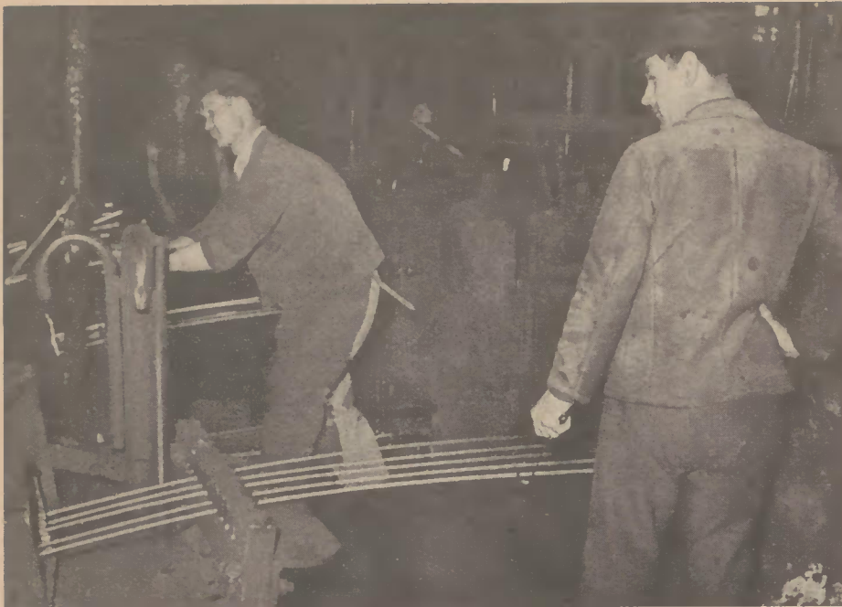
Umwalzer beim Walzen von 5-mm-Draht
