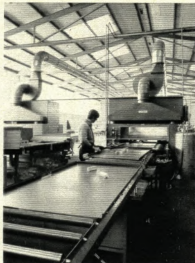
◀ Die Schloßkästen für die Türschlösser werden genietet
